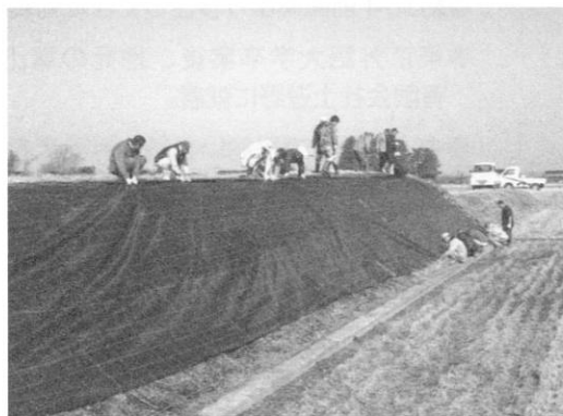
高畦での防草シート張り
